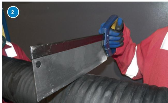
Отрежьте шланг по разметке с помощью острого, увлажненного режущего инструмента (например ножом или беззубной ножковкой) до проволочной спирали.
